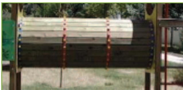
**EN 1176-1 4.2.7.4 Atrapamiento de cuerpo completo:** Los túneles en los cuales se arrastre el cuerpo completo y partes suspendidas rígidas o que tengan suspensión rígida no se podrán producir atrapamientos del cuerpo. Para ello, los túneles deberán cumplir los requisitos de la **tabla 1 del apartado 4.2.7.4 de la Norma UNE EN 1176-1**.
