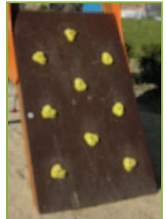
**EN 1176-1 4.10 y 4.11 Uniones y elementos reemplazables:** No podrán soltarse sin herramientas. Si se producen pérdidas de lubricante no deberán ensuciar el equipo y afectar a su uso seguro.
