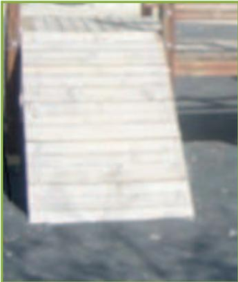
*EN 1176-1 4.2.9.4 Elementos de juego empinado: Para los elementos de juego empinado en partes de elementos fácilmente accesibles, la abertura de las barreras deben ser máximo de 500 mm y la altura de caída máxima de 2000 mm.*
