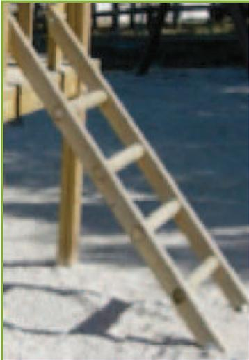
Los travesaños y peldaños deben estar equidistantes (*no aplica al último con la plataforma o al primero con el suelo, ni a las escalas de cuerda*) y no pueden rotar (no pueden estar fijos sólo con clavos o tornillos de madera). Deberá haber espacio sin obstrucción de 90 mm por su parte posterior, medido desde el centro del peldaño o travesaño, con 90° respecto a la escalerilla.
