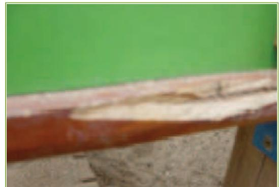
**EN 1176-1 4.2.5. Acabado del equipo:** No deberán sobresalir astillas, ni clavos, ni terminaciones de cables de metal trenzados, ni deberá haber componentes con bordes afilados o puntiagudos.
