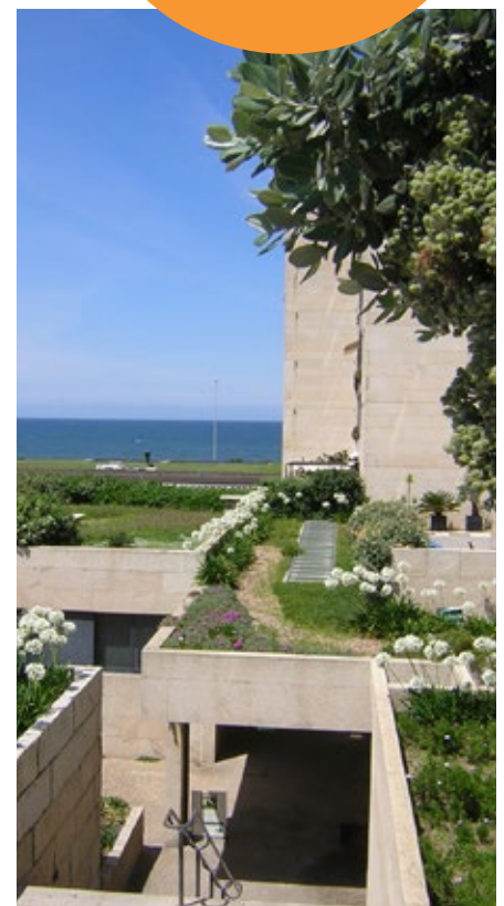
Coberturas Jardim - Porto
