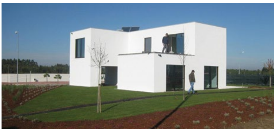
Coolhaven: IParque em Coimbra (Construção modular: ITE em suporte de OSB (material derivado da madeira))
