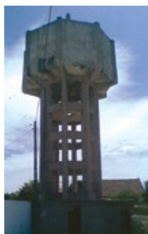
Reservatório da Lardosa- Antes
