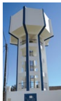
Reservatório da Lardosa - Depois
